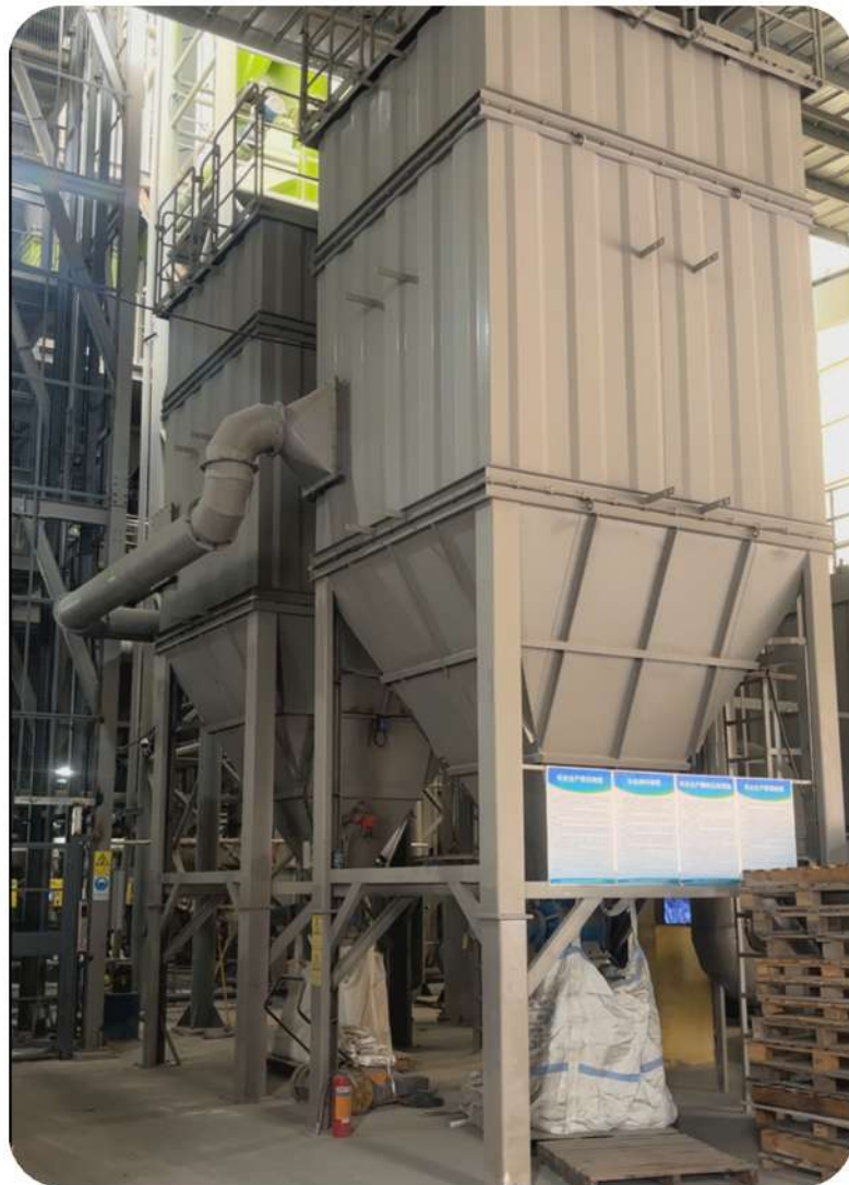
Silos de armazenamento:
